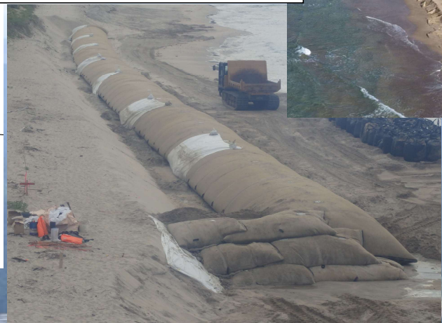
サンドバック設置完了後
