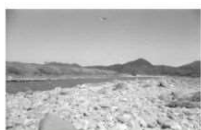
昭和40年以前の小鴨川7.0km下流の状況
