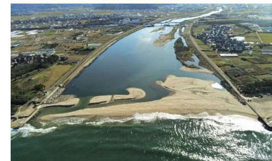
天神川河口砂州の状況 (令和5年12月4日)
