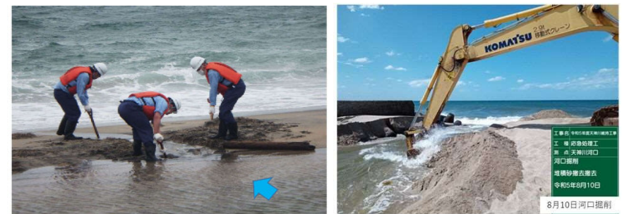
維持掘削状況 (左：令和4年6月13日 右：令和5年8月10日)
