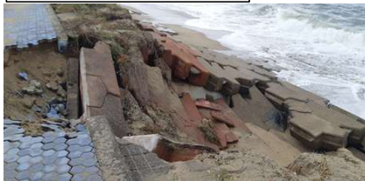
R3.10.21護岸損傷状況
