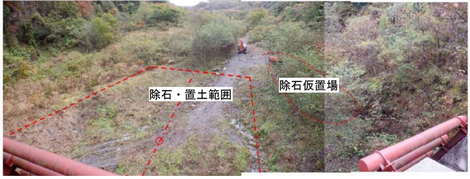
伐採後・掘削前
