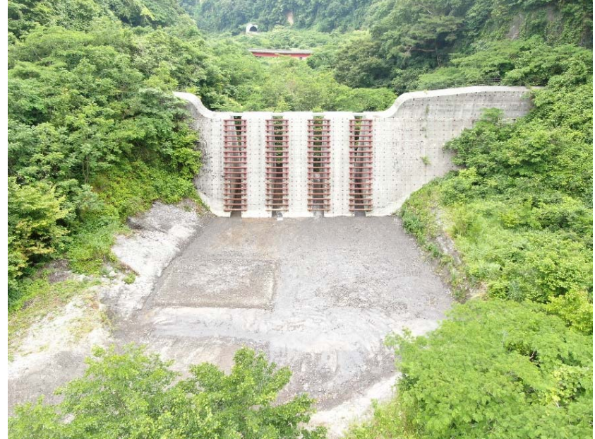
掘削+置き土の工事後(2023(令和5年).6)
