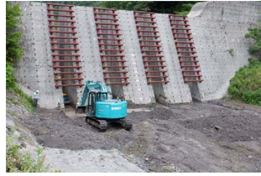
スリット内礫樹木等除去
