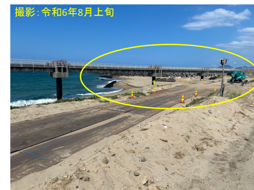
写真-2 拡張工事区域(埋め立て区域)
