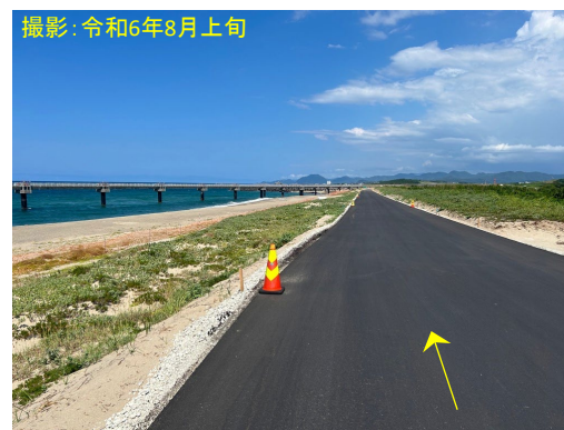
写真-1 工事用道路(国道9号からの進入路)
