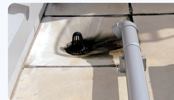
屋上の集水口
