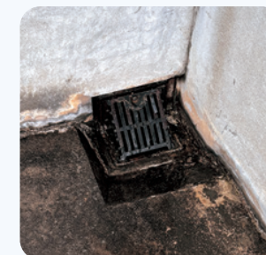
屋上の集水口
