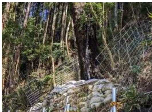
対策状況 イノシシ柵、土壌崩壊箇所への土嚢積直し等
