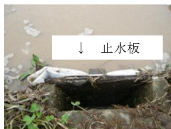
止水板の設置
