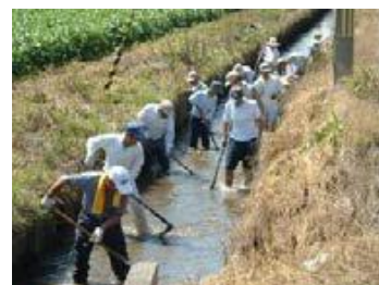
農業用水路の泥上げ
