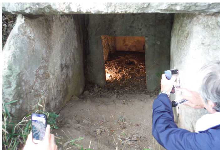
山ヶ鼻古墳 （切石積みの横穴式石室）
