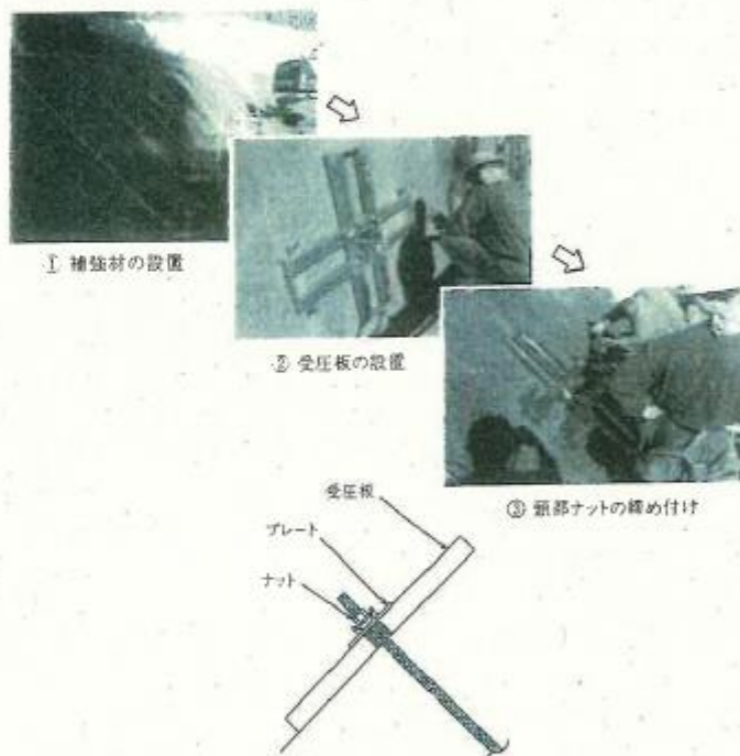
解説図-6.15 独立受圧板設置例
