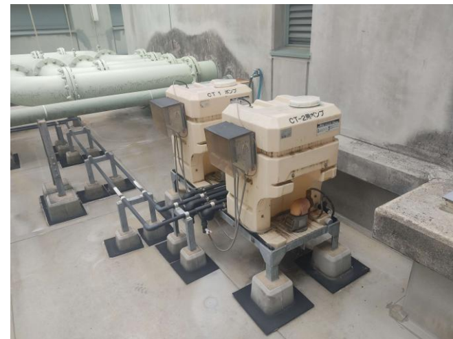
▲既設薬注装置2台（タクミナ製 型式：PTU-100）
