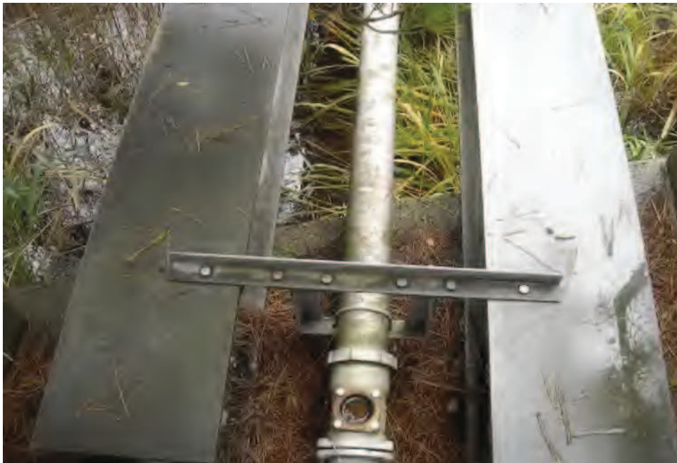
公共樹付近下水添架管
