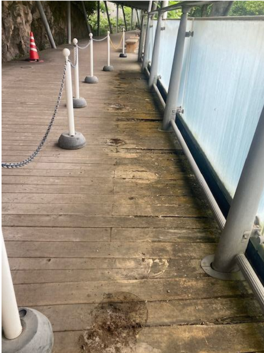
とっとり花回廊テラス他舗装改修 D 展望回廊床材
