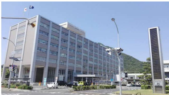
鳥取県庁本庁舎外観
