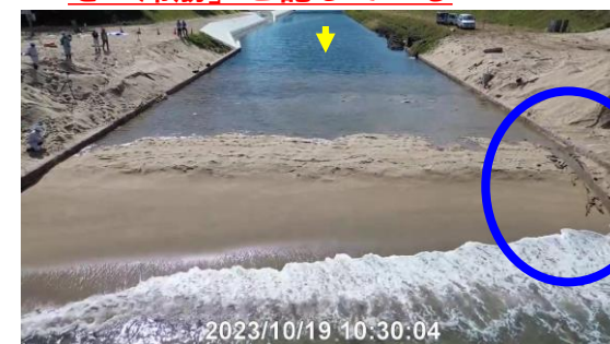
(c) 滞筋（水みち）が海側と接続
