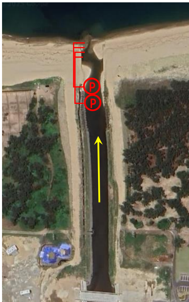
平面イメージ（北条川放水路の空中写真）
