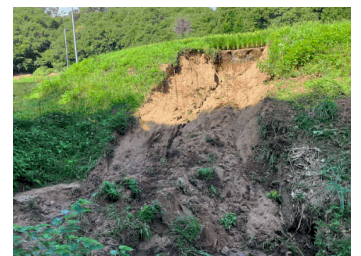
伯耆町の水田の法面崩壊の状況（8月15日時点）
