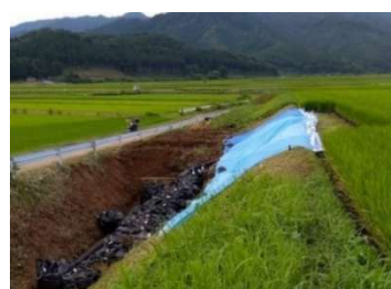
鳥取市気高町の閉塞した排水路の応急復旧状況（8月12日時点）
