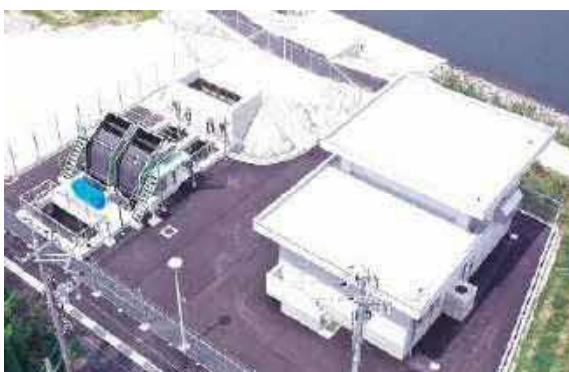
イメージ図(図は稼働中の龍島排水機場)
