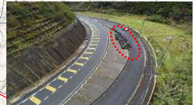
<日野町管内対応用土のう仮置場>
