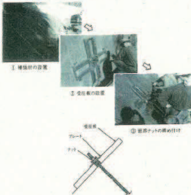
解説図-6.15 独立受圧板設置例
