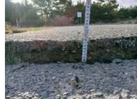
農道の沈下（弓浜）
