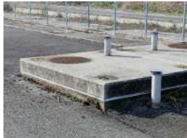
補水槽周り舗装沈下（彦名）
