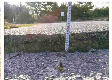
農道の沈下(弓浜)
