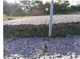
農道の沈下(弓浜)
