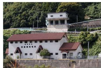
新幡郷発電所 外観
