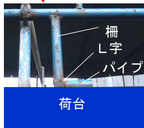
L字の柵脚を荷台上部のパイプに差込む
