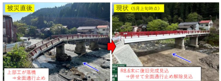
市災害 高山橋（佐治町高山地内）復旧状況
