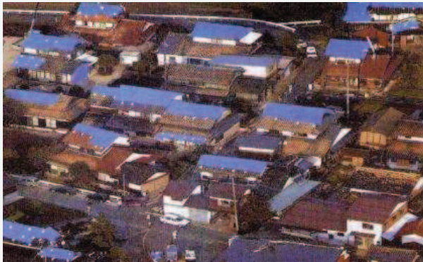
屋根にブルーシートがかけられた住宅(日野町)
