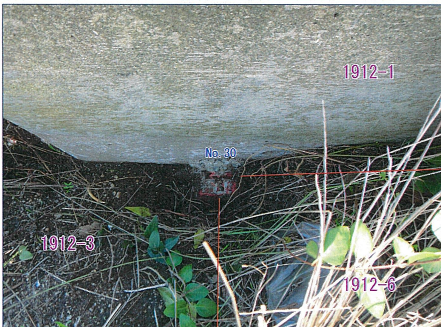
No. 30 標識: コンクリート杭 (既存)
