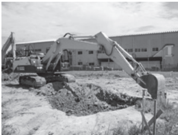
写真5 重機による表土掘削
