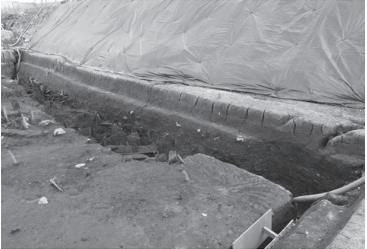
1 調査区南壁土層断面（北西から）
