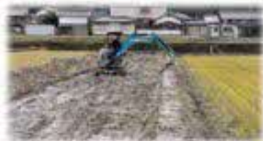
畦畔補強の施工状況
