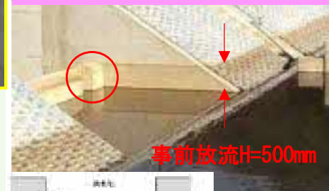
洪水吐越流堰スリット
