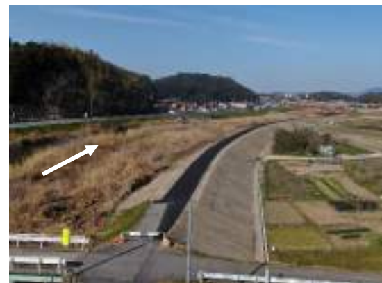
①境地区 堤防工事 R8.3.17撮影
