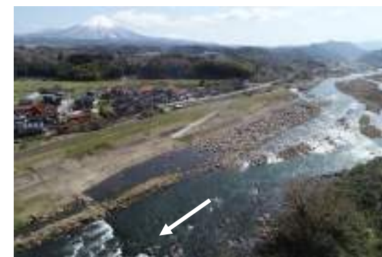
②岸本地区 河道掘削工事 R8.3.11撮影
