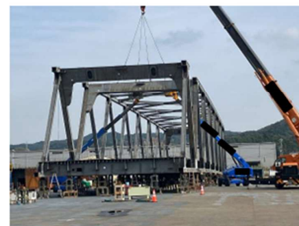
トラス仮組立状況
