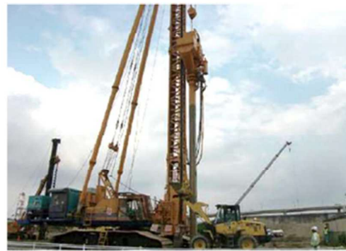
軟弱地盤処理工
