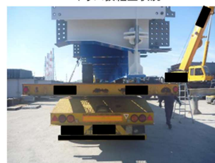
鋼床板鋼桁輸送状況
