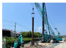
鋼管ソイルセメント杭工
