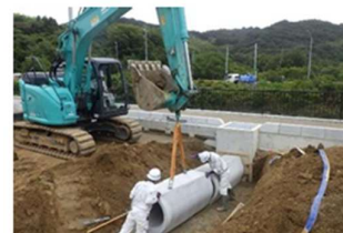
排水構造物工 (鉄筋コンクリート台付管)
