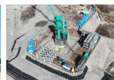
ニューマチックケーソン工
