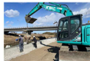
笠コンクリートブロック据付工
