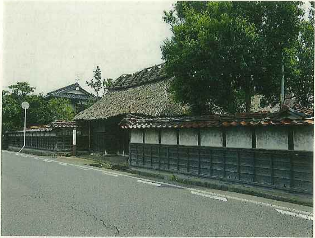
敷地正面(西面)
