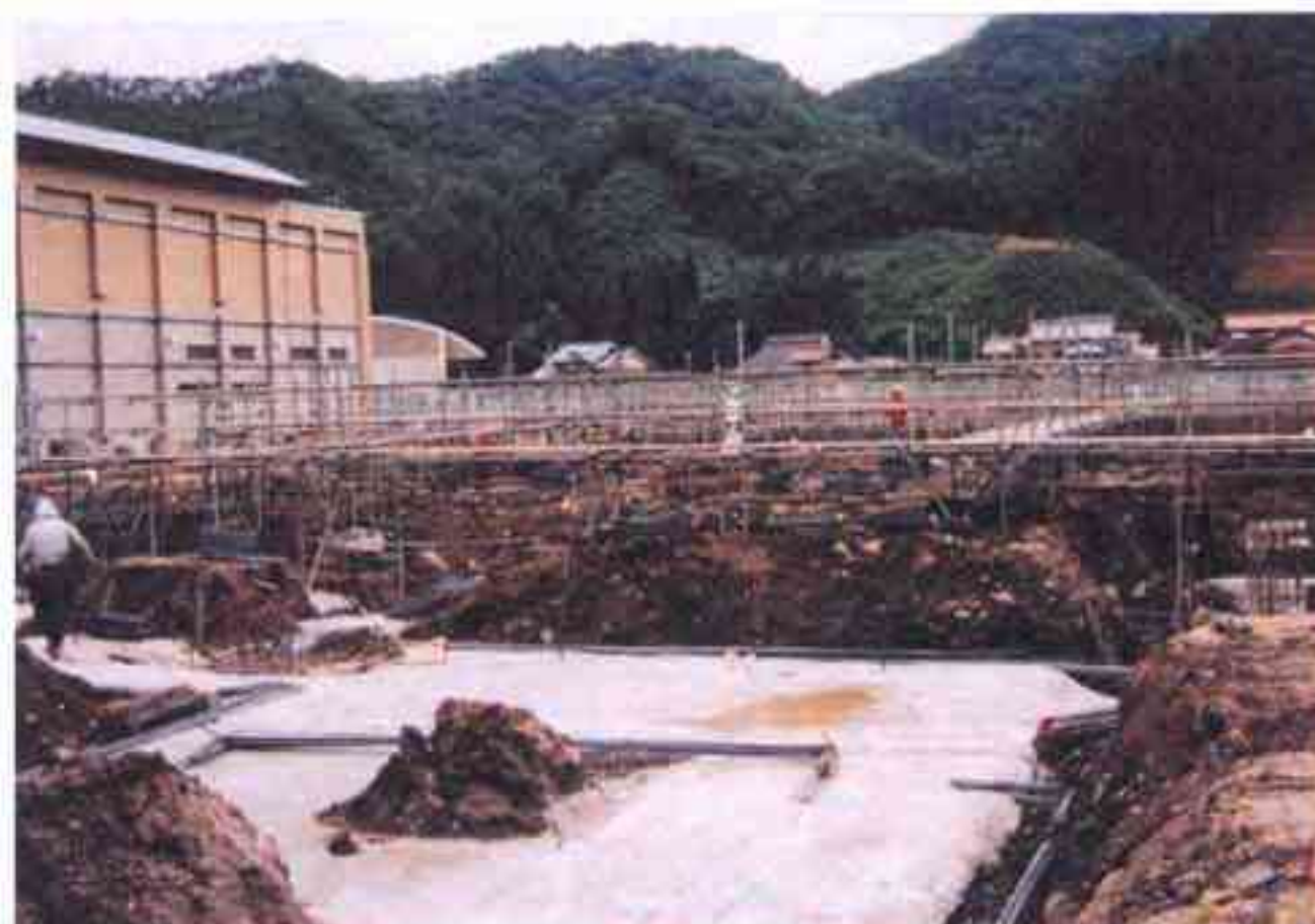
平成14年3月末の完成を目指して 建設中の日南町役場
