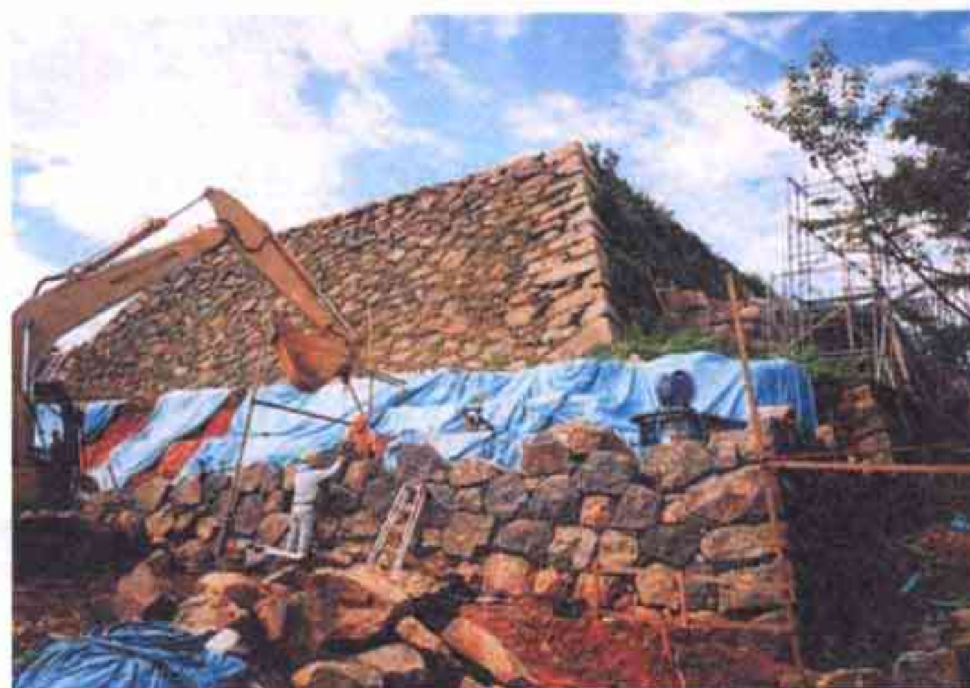
地震で崩れた米子城址石垣の復旧工事 (米子市)
