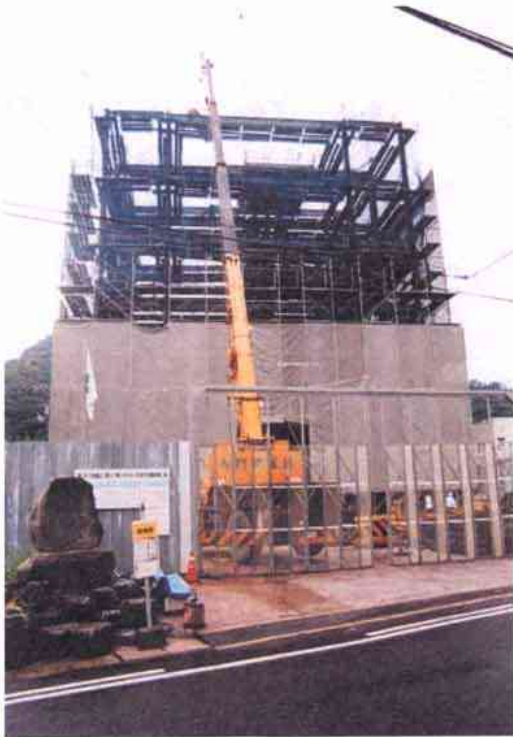
建設中の溝口町役場
