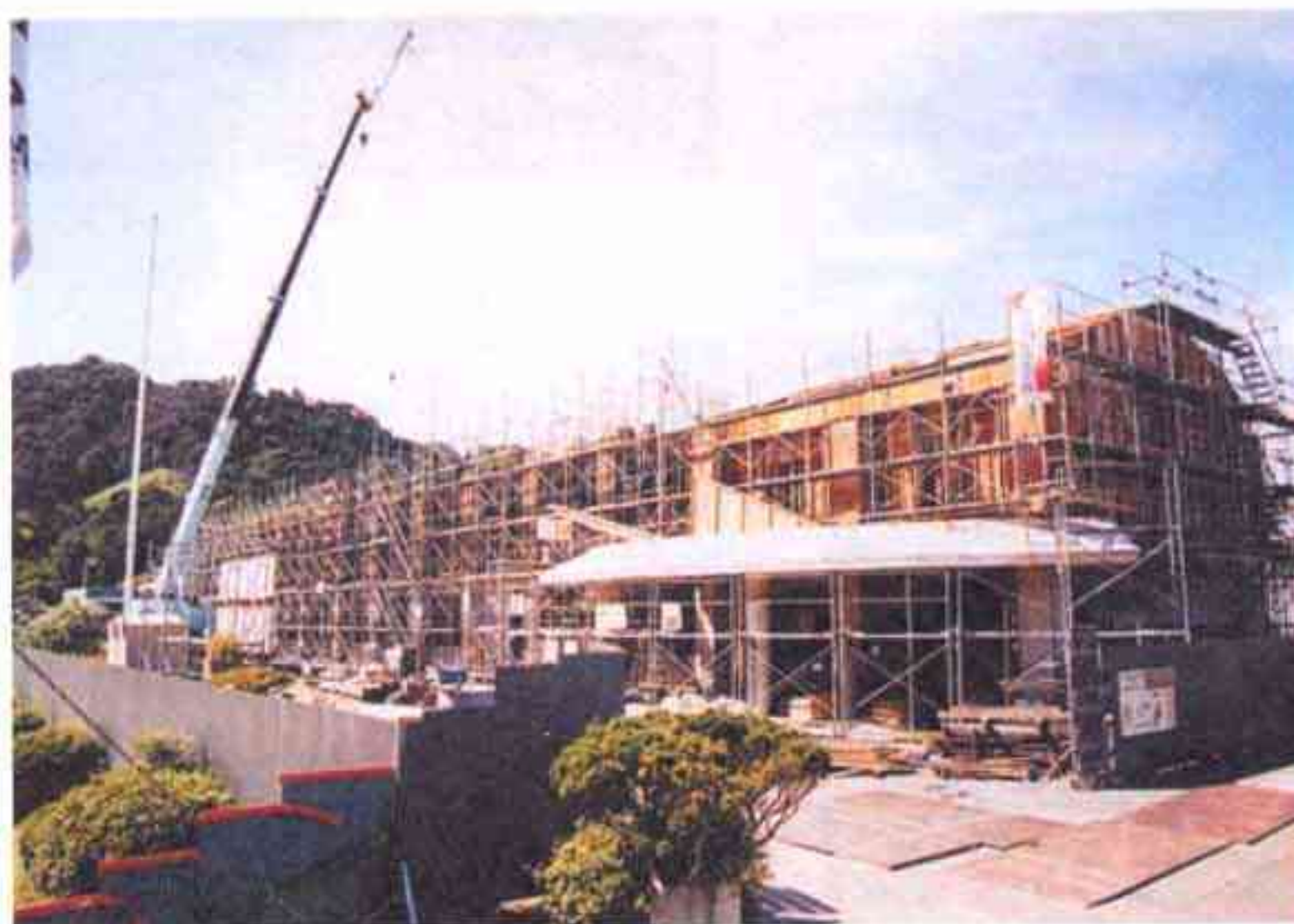
建設が進む新校舎
