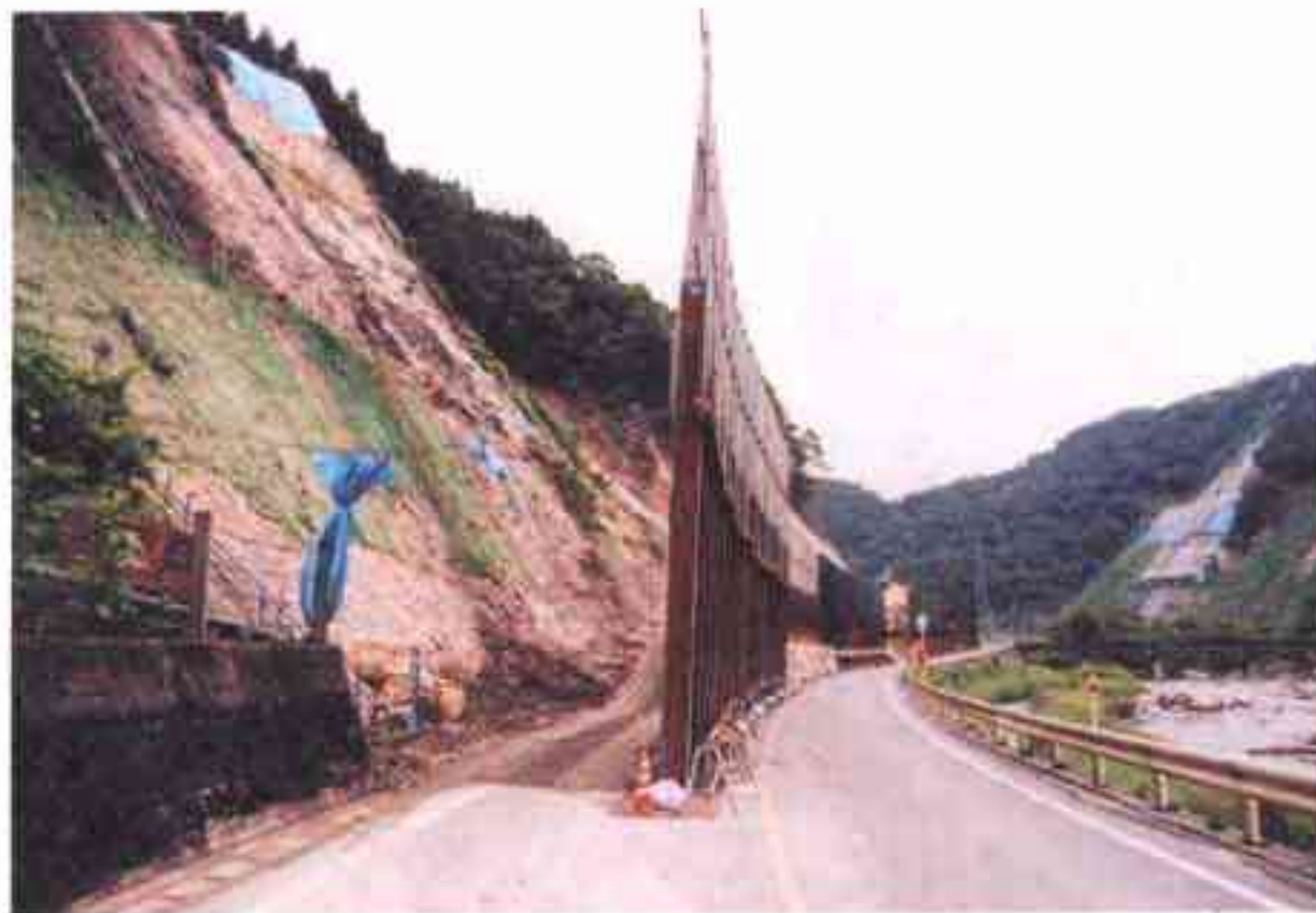
国道180号の法面復旧工事現場 (日野町)
