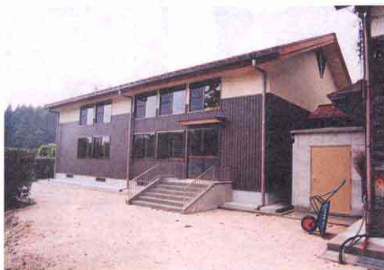
完成した日光小学校添谷分校体育館
