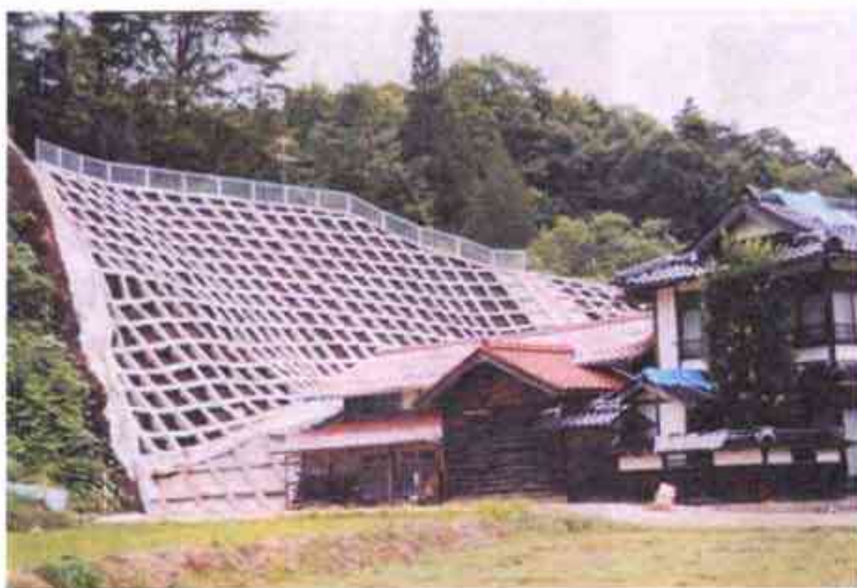
補強工事の終わった民家裏の 土砂崩れ現場(西伯町)
