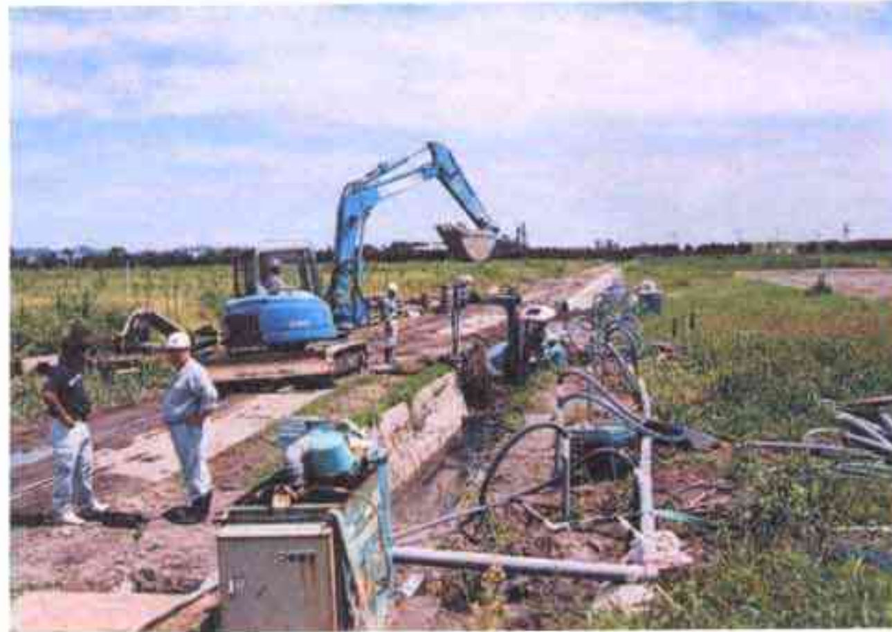
中海干拓弓浜工区での排水路の補修工事 (境港市)
