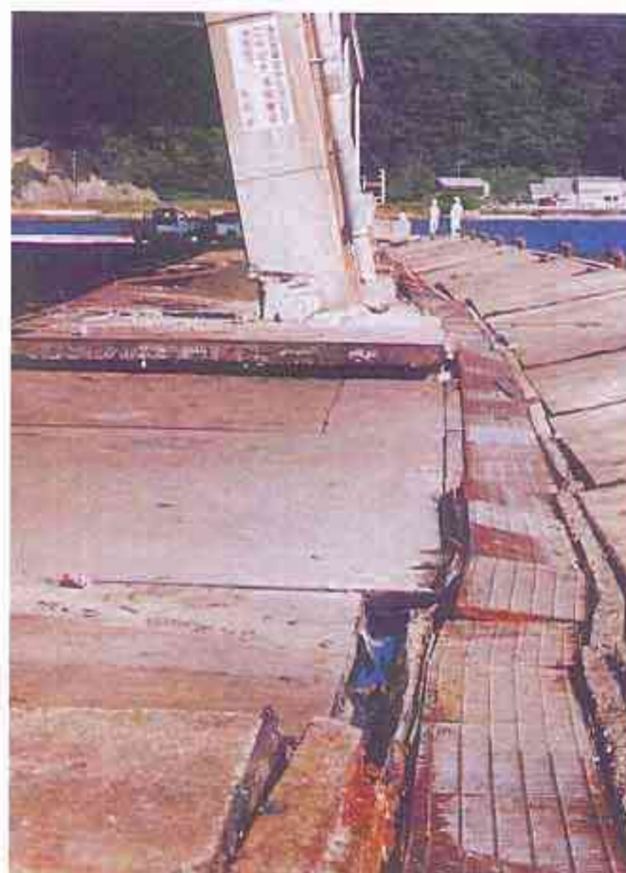
約120m湾曲したかにかご岸壁
