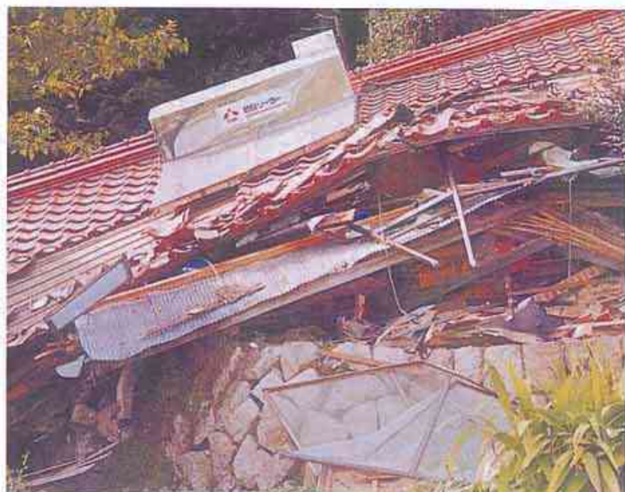
強い地震により全壊した家屋
