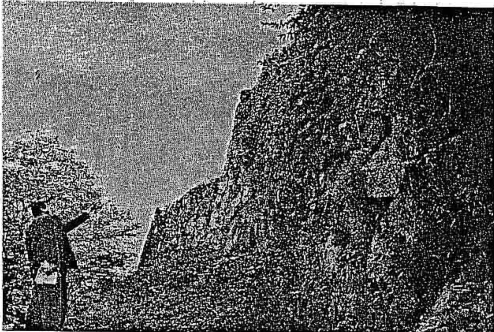
石垣が崩らみ、崩落寸前の米子城跡を調査する市教委職員(米子城天守閣跡で)
