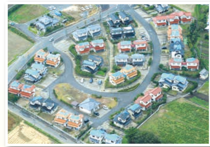
ブルーシートが掛けられた家
