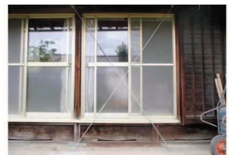
<低コスト耐震改修工法の事例>
