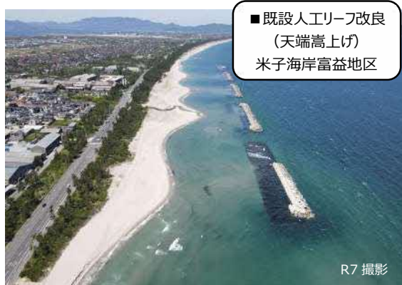
既設人工リーフ改良整備状況
