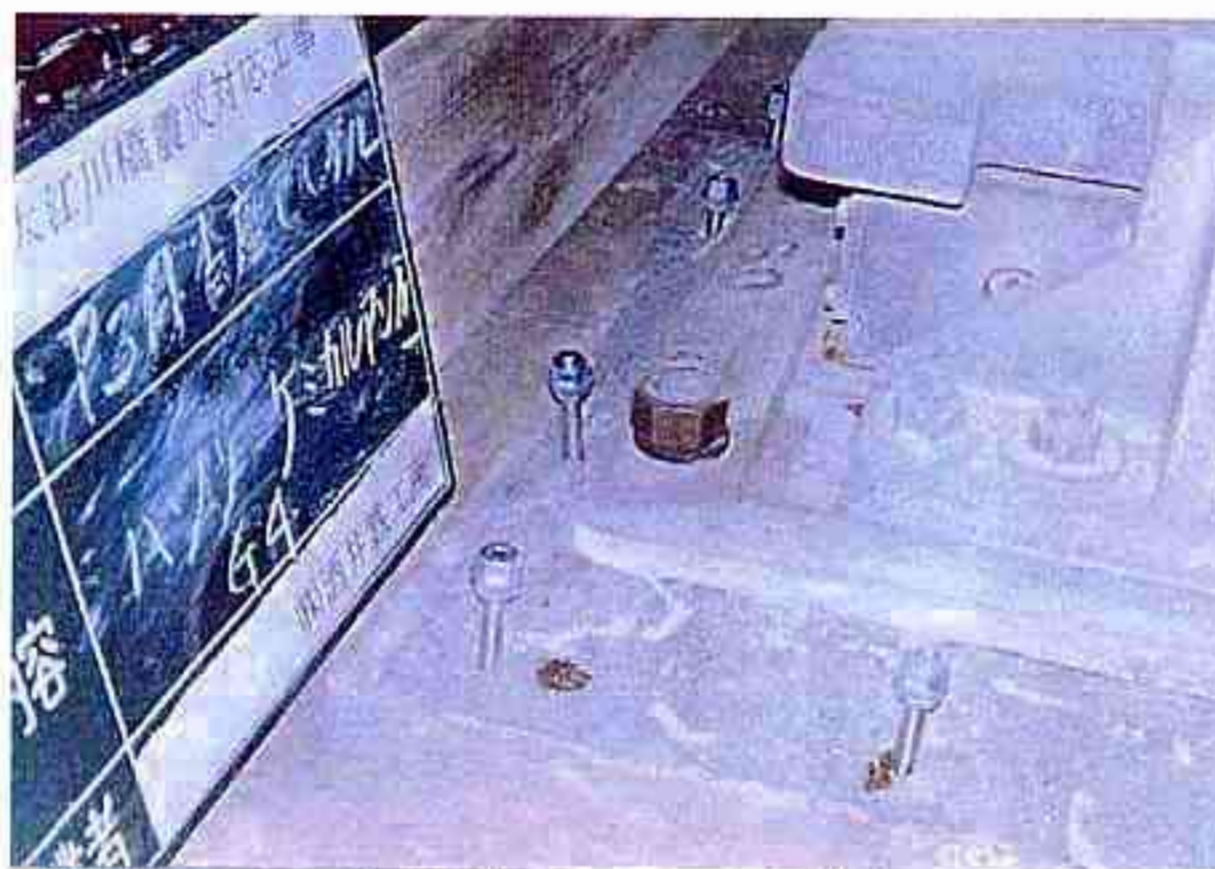
写真 5-25 無収縮モルタル打設
