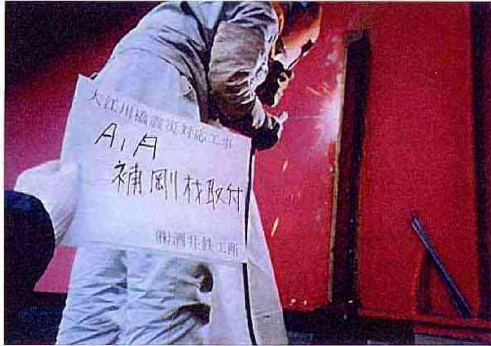
写真 5-22 補強材現場溶接取付
