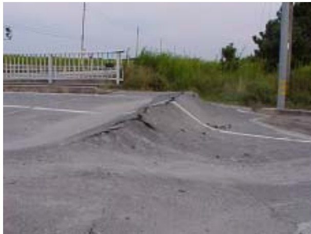
写真5 境港市竹内団地 埋め立て地との境目では地盤の歪みの差で大きく道路が隆起。
