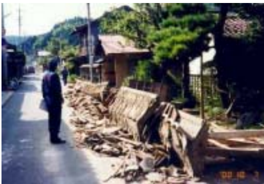
写真9 日野町黒坂 民家外壁の倒壊。
