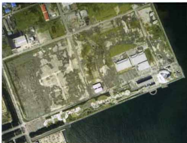
空中写真-1 竹内団地南部
