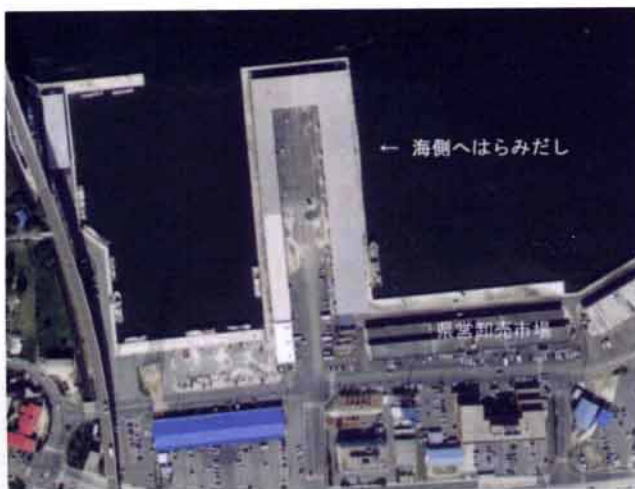
空中写真-2 境港卸売市場(カニかご岸壁)
