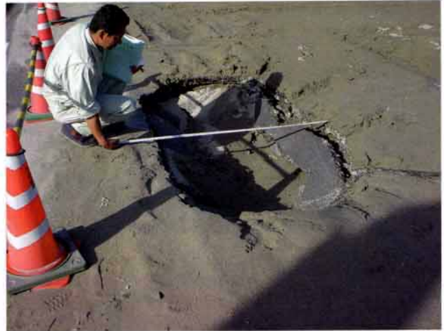
写真-19 巨大な噴砂口
