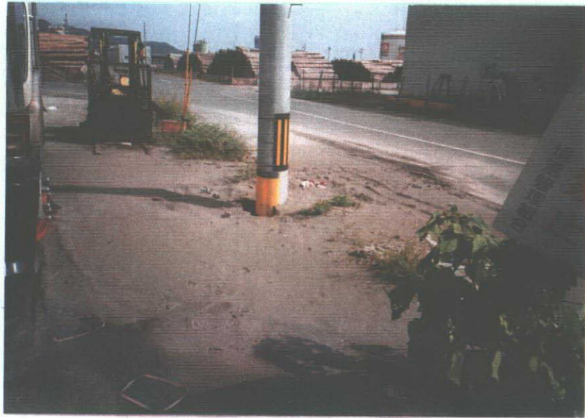
写真-13：電柱回りの噴砂と電柱の沈下。
