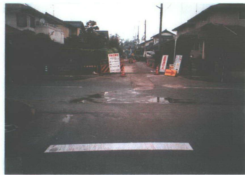
写真-3 地震で下水道管が壊れ復旧工事を 行っている。
