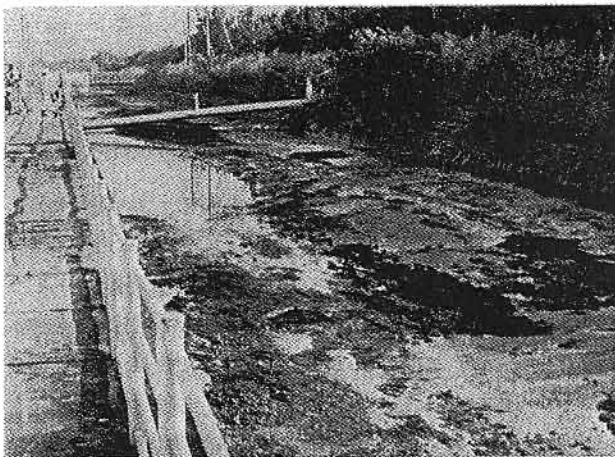
写真-2 承水路での噴砂
