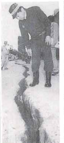
長さ約250分の亀裂が入った堤防の四方、岸壁=7日午前10時20分、鳥取県境港市昭和町
