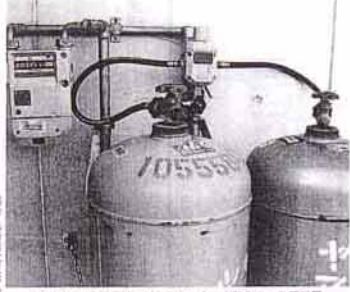
プロパンガス漏洩はマイコンメーターと換気ホースで地震に備えたい
