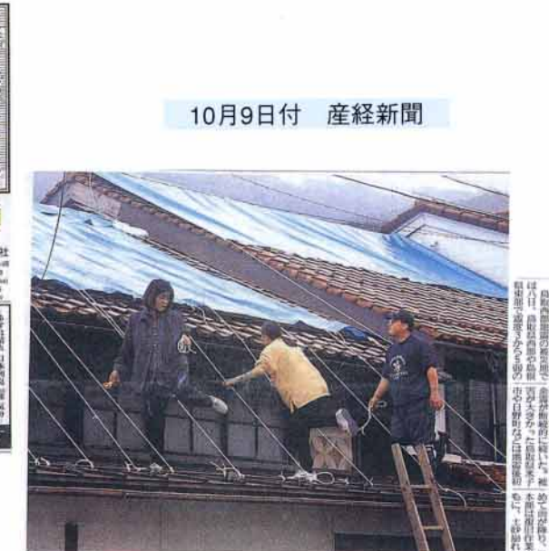
地震後初めての本格的な雨に備え、自宅の屋根にビニールシートを張る
