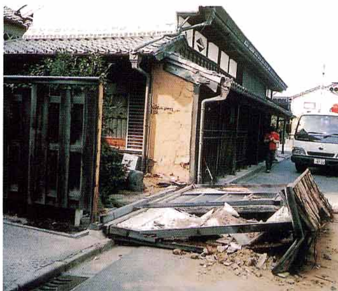
米子市内の後藤屋土塀倒壊
