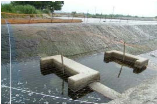
遡上アユを守るため、ネットを魚道に設置 (日野川下流部)
