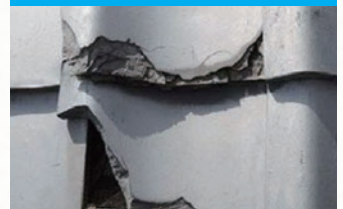
瓦が著しく破損している例
