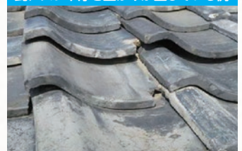
瓦が著しく破損している例
