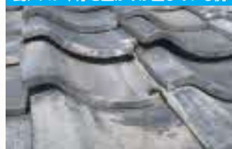
瓦が著しく破損している例
