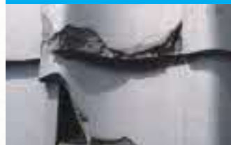
瓦が著しく破損している例
