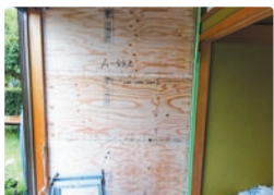
▼ 縁側 (構造用合板による補強)
